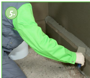
5. Faseta uszczelniająca z zaprawy KÖSTER Sperrmörtel
