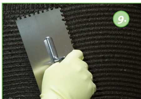
9. Nakładanie drugiej warstwy KÖSTER Deuxan 2K
